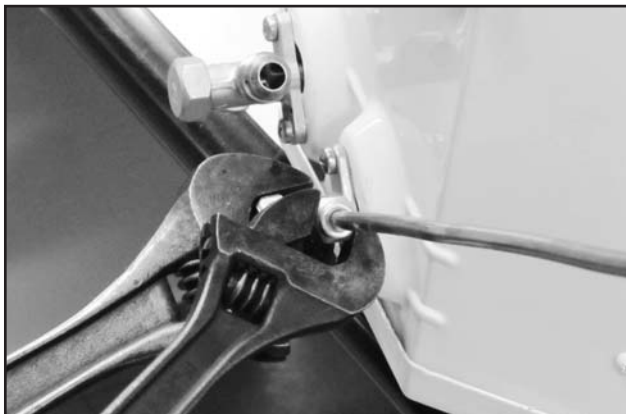
FIG. 25 - FIXAÇÃO DA PORCA
