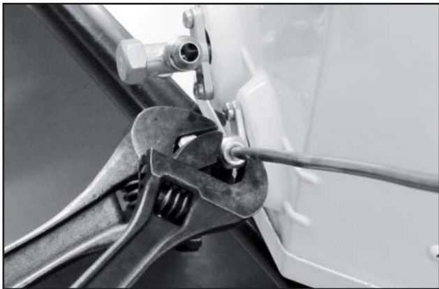
FIGURA 25 - FIXAÇÃO DA PORCA
