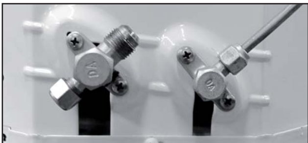
FIGURA 26 - CONEXÃO DA LINHA DE EXPANSÃO DA UNIDADE CONDENSADORA
