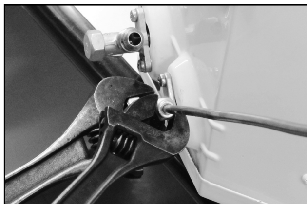
FIGURA 31 - FIXAÇÃO DA PORCA
